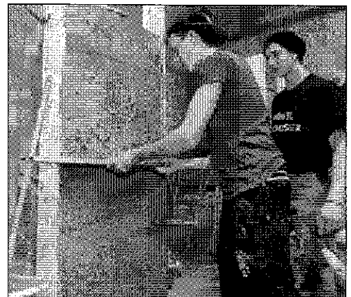
Worauf man beim Anrühren und Auftragen von Mörtel sowie beim Verputzen einer Ziegelwand achten muss, erklärten Gesellen den Jugendlichen.
